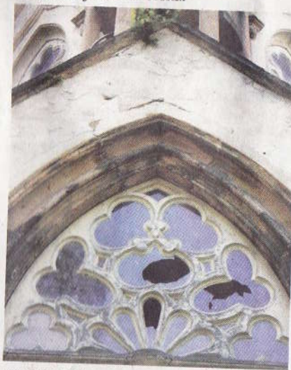
Vitrážové okno novogotického templu.
